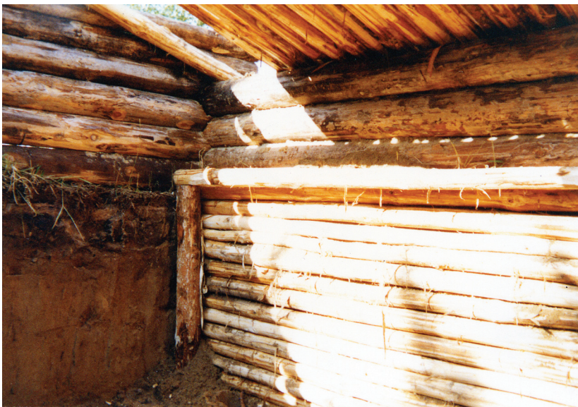
Илл. 62–63. Этапы строительства нового карамо в пос. Тюхтерево. Фото: Н. А. Тучкова, 1995 г.
